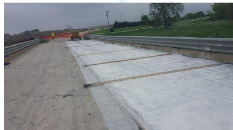
Вся площадь закрыта защитной пластиковой пленкой
