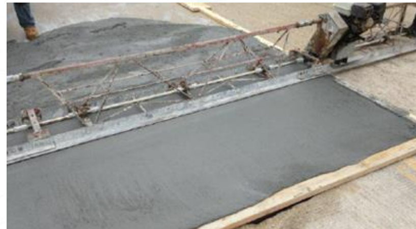
Укладка смеси с помощью виброрейки
