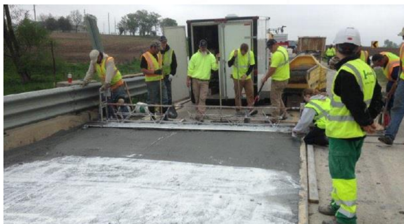
СПФ уложен по всей первой полосе, защита поверхности
