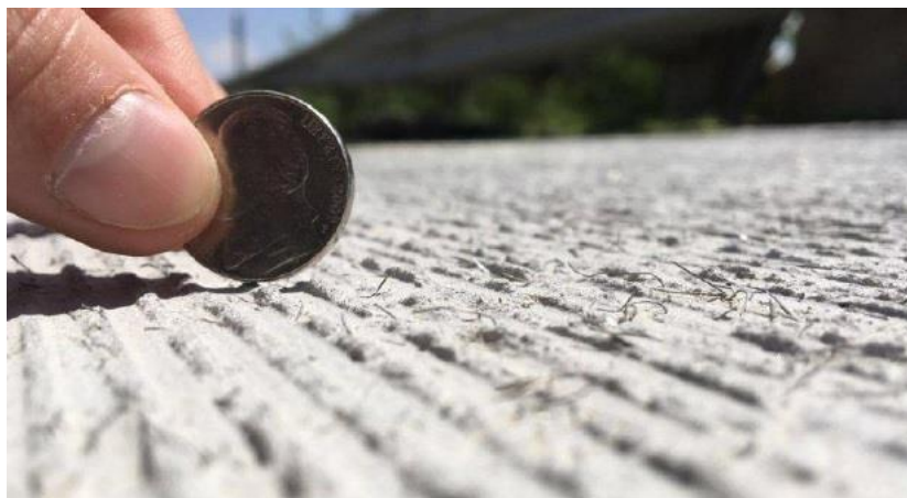
Подготовка поверхности UHPFRC для движения транспорта
