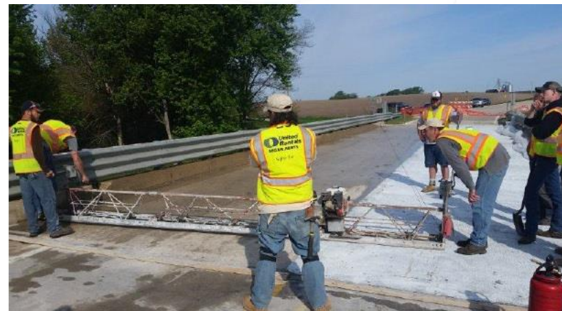
Установка выброрейки для работы на правой стороне
