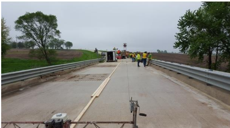
Поверхность готова для нанесения добавленного слоя
