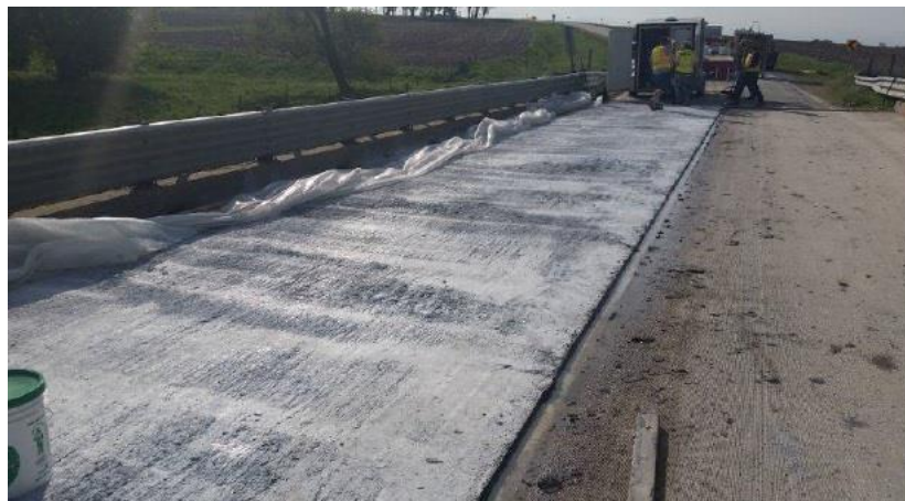
Работа на левой полосе полностью закончена
