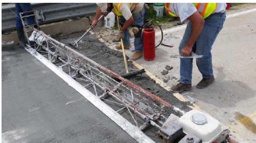
Конец укладки смеси на второй стороне
