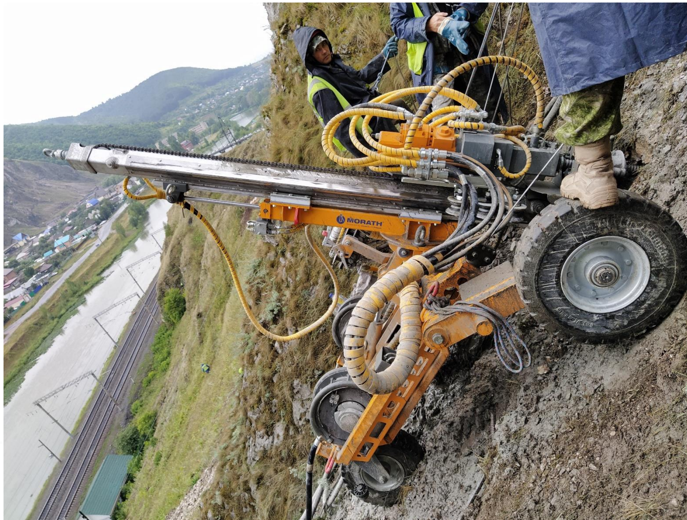
Забуривание анкеров на склоне. г. Аша, 2020 г.
